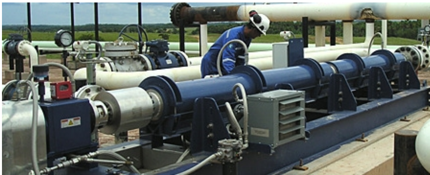
Figura 12: Bomba Centrífuga Submersa instalada horizontalmente (bakerhughes.com)
